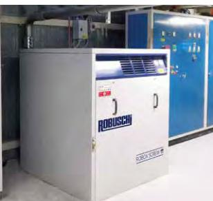
Ein bekannter Nudelhersteller installierte Robox Screw für die Pneumatische Förderung von Mehl und Zucker, vor allem wegen der niedrigen Verdichtungsendtemperatur, die das geförderte Material schont, und der herausragenden Energieeffizienz.
