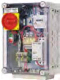
Sanftanlaufgerät für den automatischen Hochlauf eines Motors.
